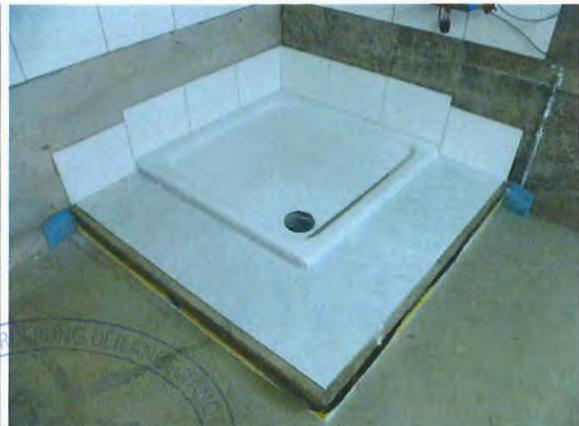
Oben links: Stahlemail-Duschwanne "Duschplan", der Fa. Kaldewei mit 4 Stk. Bitumenmatten (ca. 250 x 250 x 5 [mm]) beklebt.
