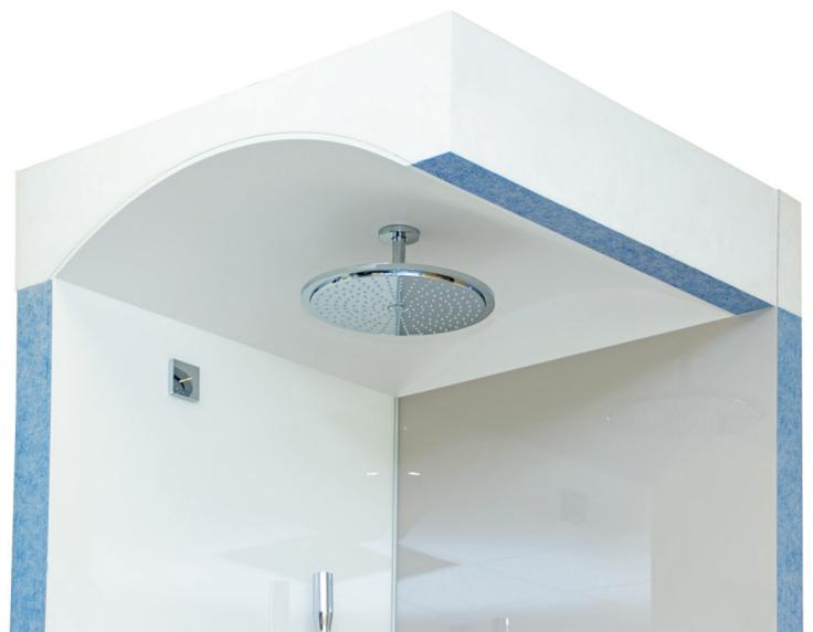
Die hochwertige Oberfläche lässt sich thermisch verformen. Dadurch können auch gewölbte Flächen wie das Tunneldach einer Dampfkabine mit Mineralwerkstoff ausgestattet werden.
